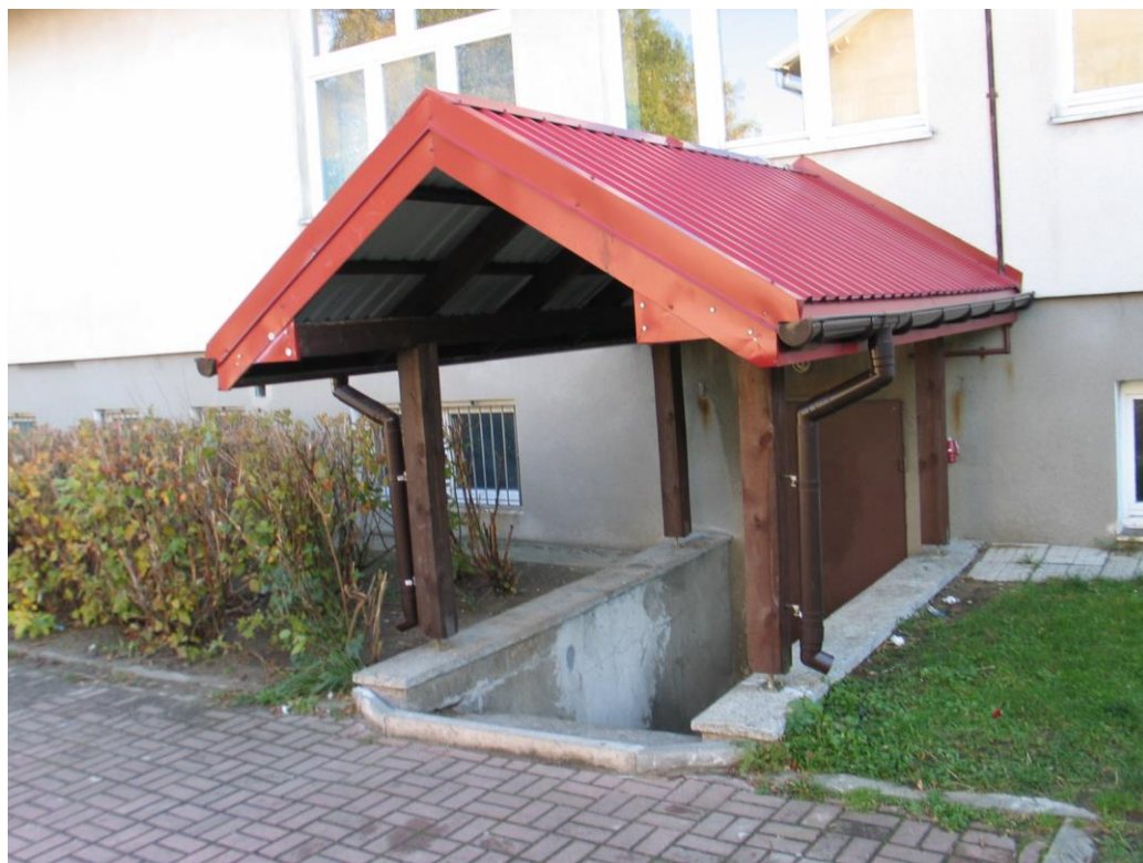
Fot.28. Pawilon ZDM – zadaszenie nad wejściem do kotłowni- strona północna
