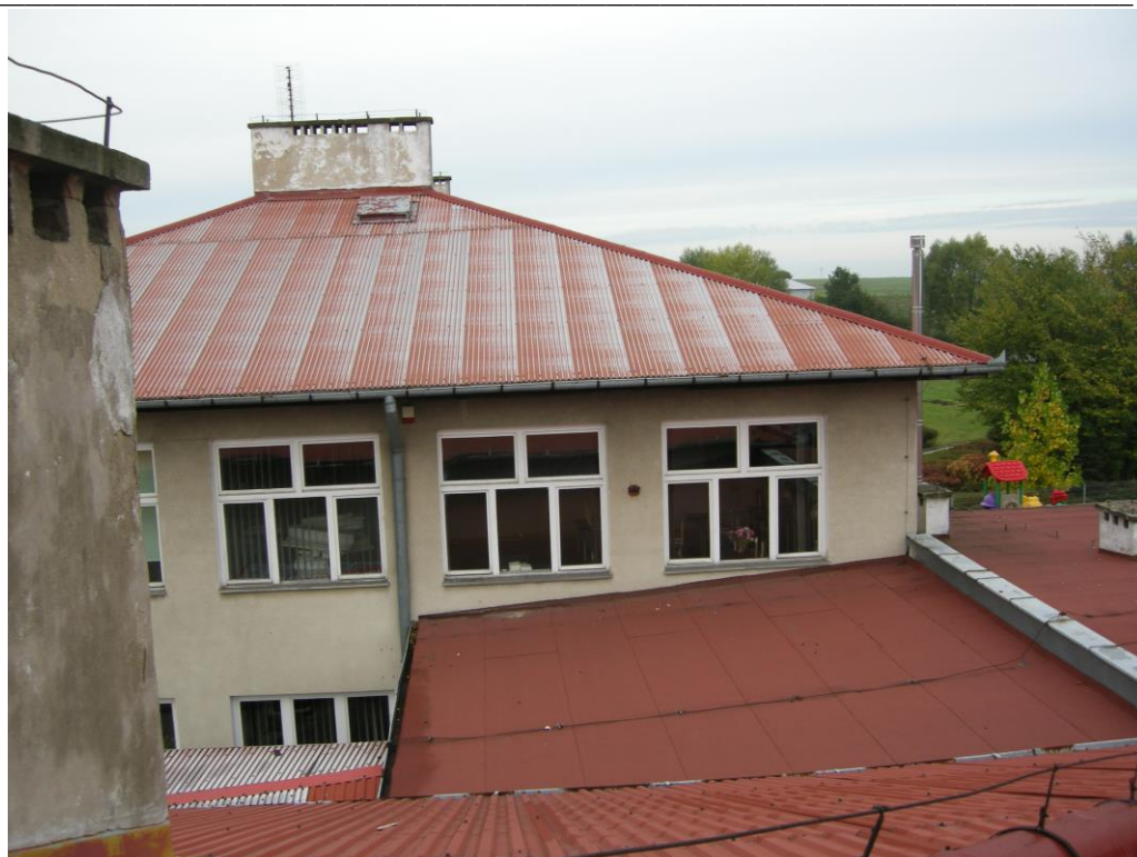
Fot.19. Dach ZDS – odbarwiona blacha trapezowa
