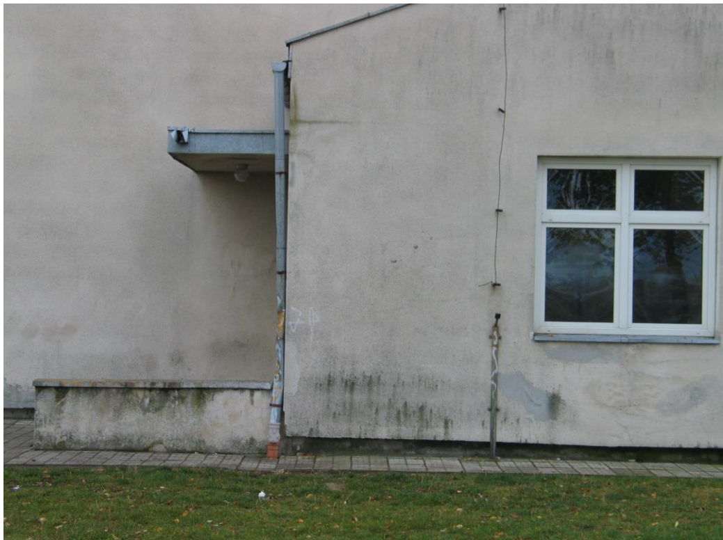
Fot.26. Pawilon ZS – zdewastowana rynna i instalacja odgromowa
