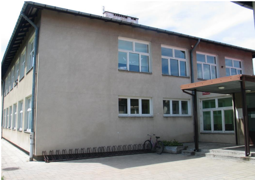
Fot.2. Pawilon ZDS- elewacja wschodnia(strefa wejściowa)
