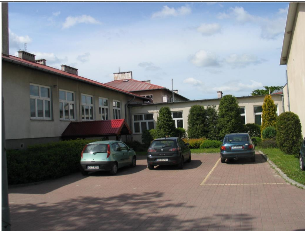
Fot.13. Pawilon ZDM i ZAK- elewacja północna ZDM i wschodnia ZAK
