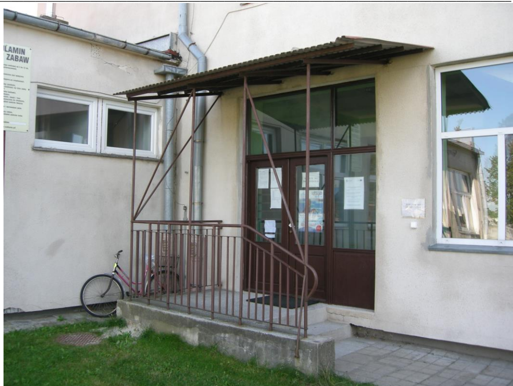
Fot.29. Pawilon ZDS – zadaszenie nad wejściem do przedszkola- strona północna
