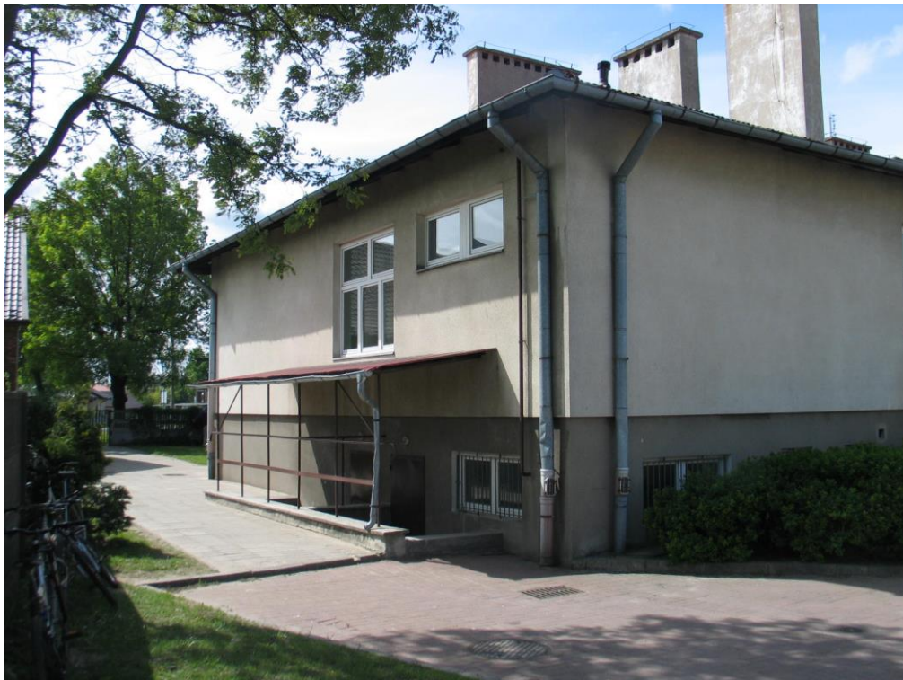
Fot.14. Pawilon ZDM- elewacja wschodnia
