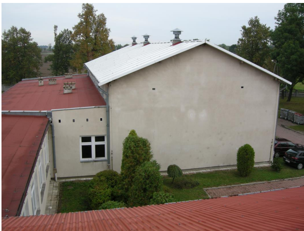
Fot.12. Pawilon ZS- elewacja południowa
